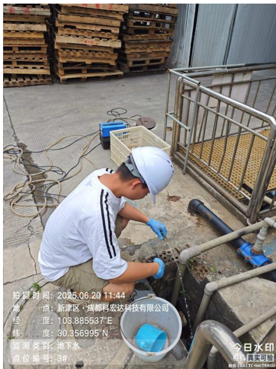
3#第一次地下水采样工作照片
